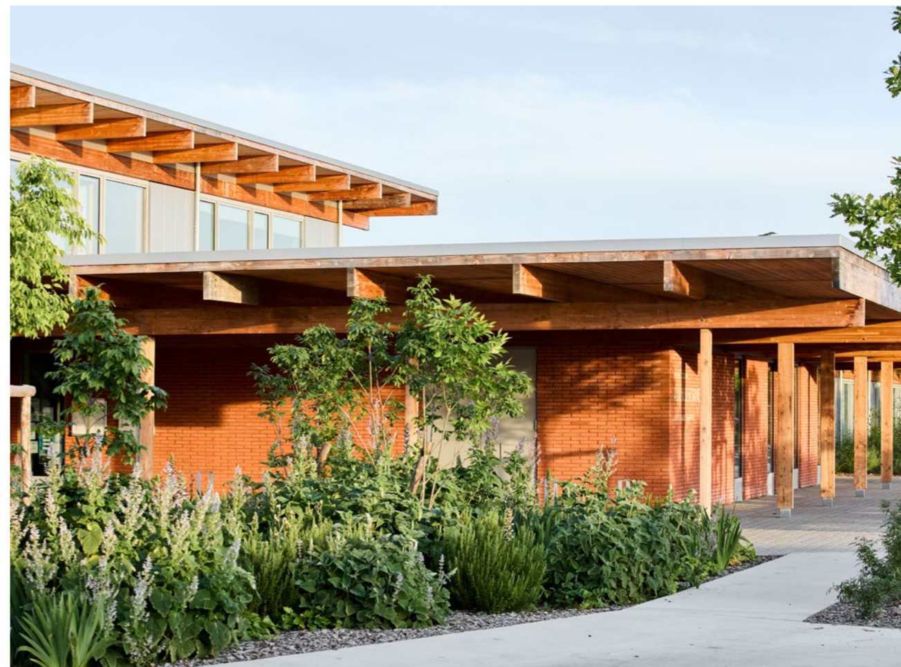
Le calme des lignes de toits et de charpentes / The quietness of the rooflines and timber structures
