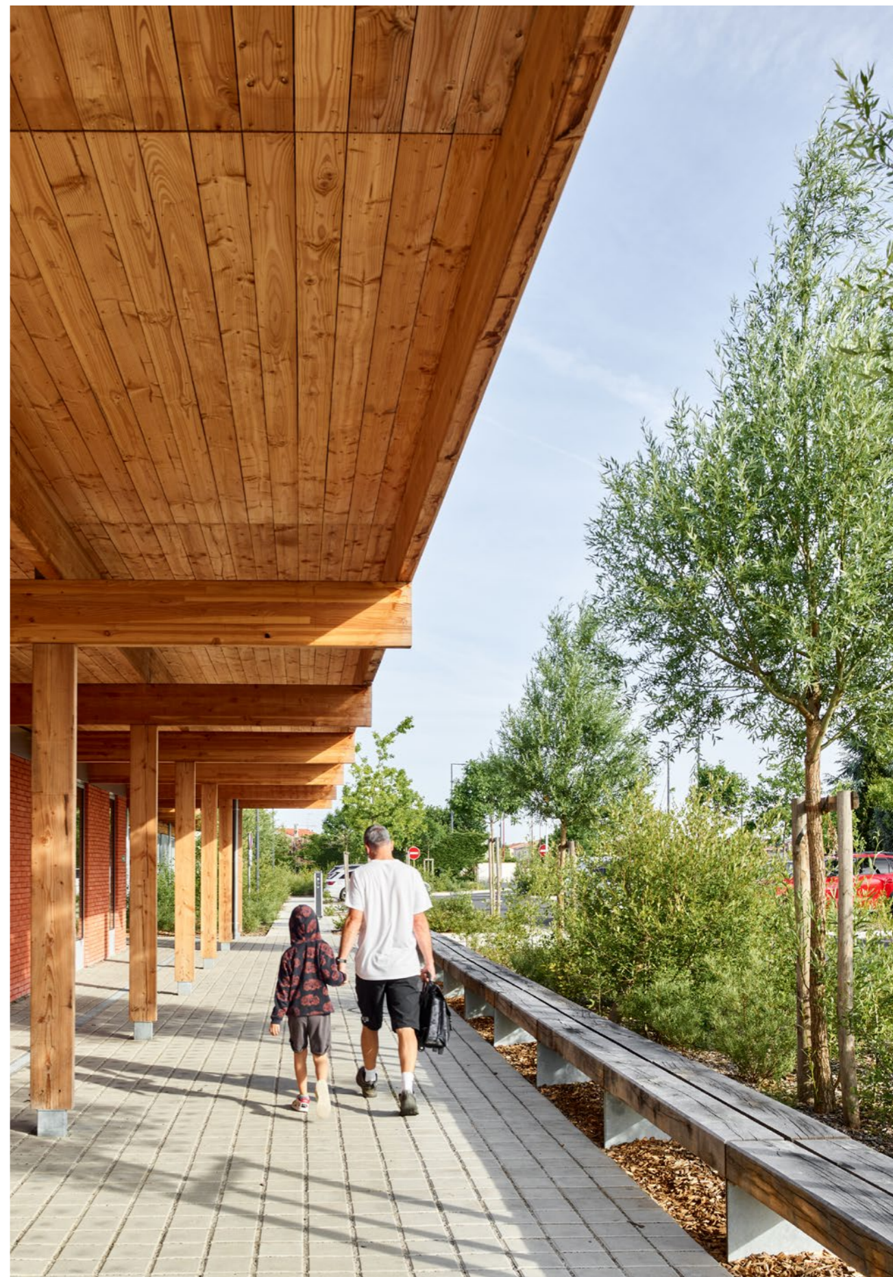
A l'abri sous les préaux et les débords de toits périphériques / Sheltered beneath the large peripheral roof overhangs
