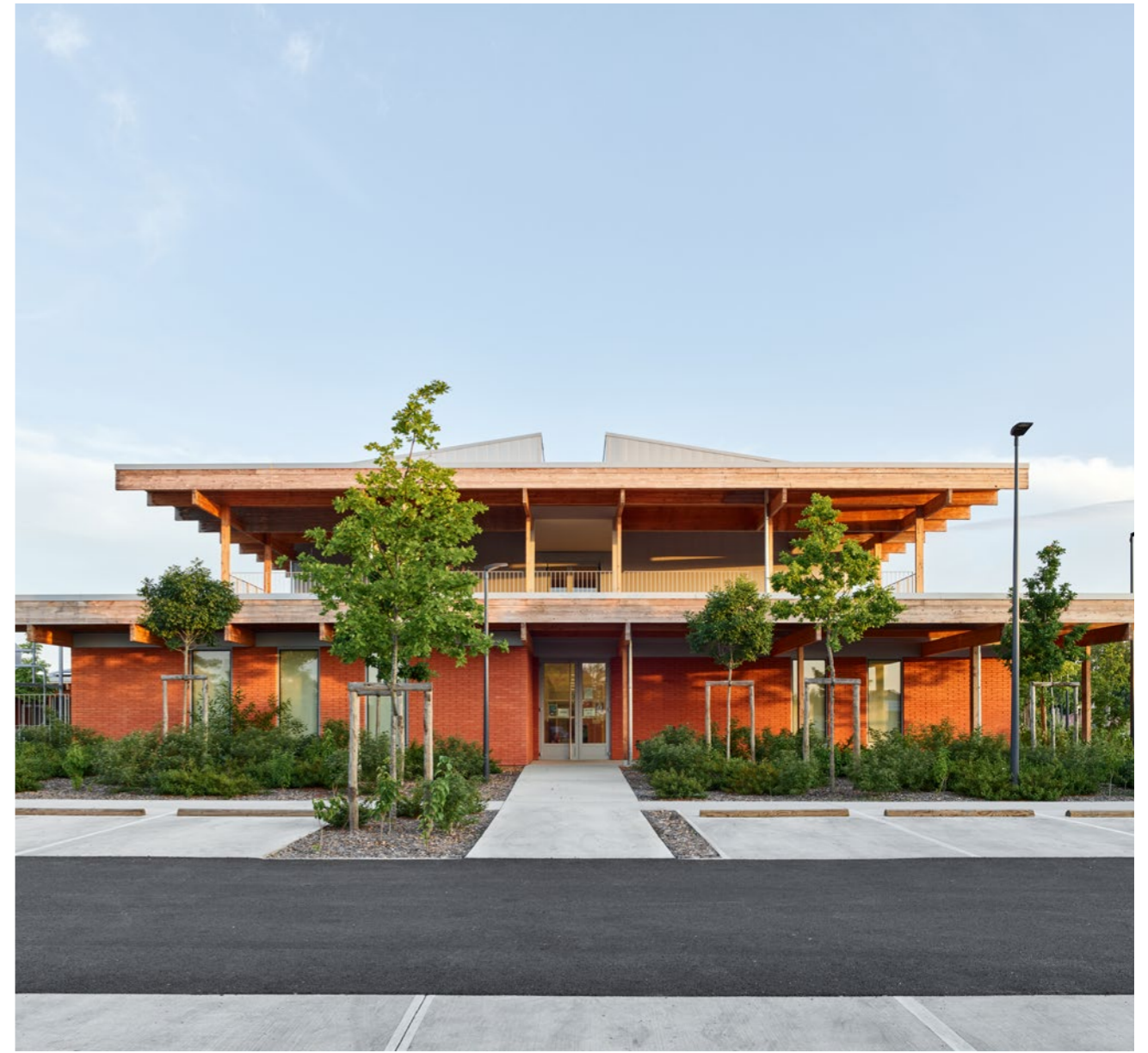
La ventilation naturelle dessine la silhouette de l'école / Natural ventilation shapes the school's silhouette
