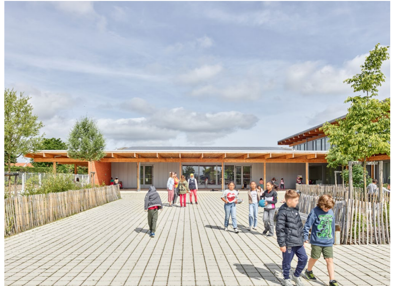
Les cours : Aires d'évolution, terrain de sports, bancs et carrés plantés / Playgrounds : Activity areas, sports court, benches and planted beds
