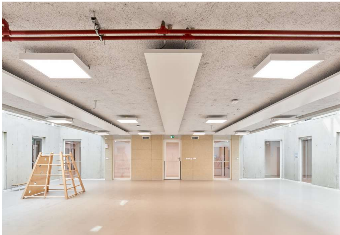
Patio/salle de motricité - Des matériaux laissés brut. Patio/motor skills room - Exposed raw materials.
