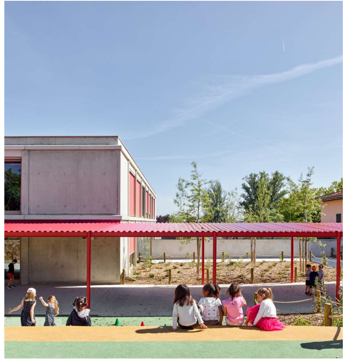
Une structure apparente visible sur toutes les façades. An exposed structure visible on all facades.
