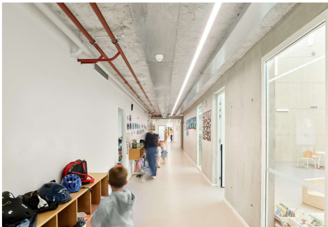
Les réseaux laissés apparents. The water and electrical networks left exposed.
