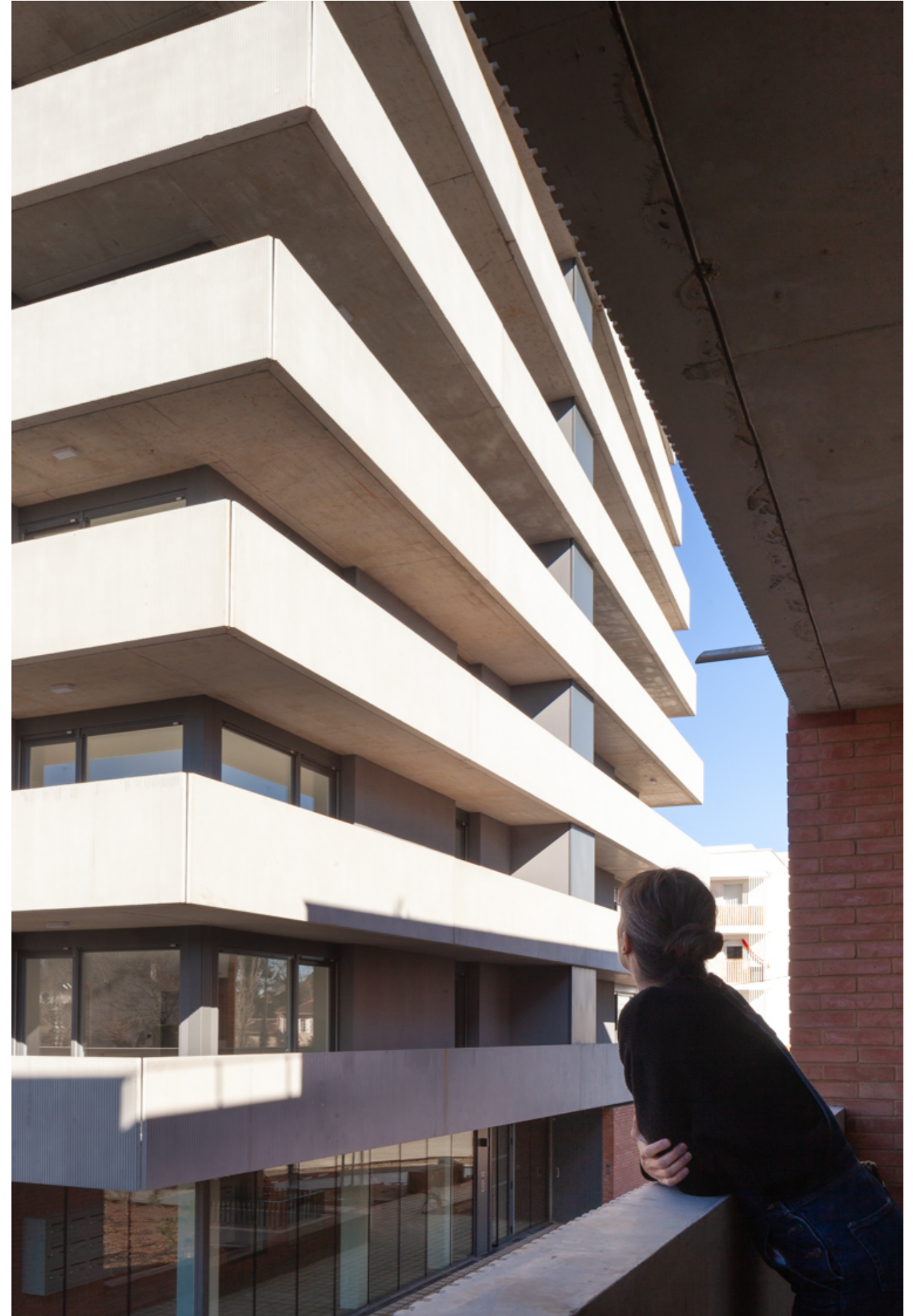
Les garde-corps en béton matricé jouent un rôle important pour l'intimité. The patterned concrete railings play an important role in providing privacy.
