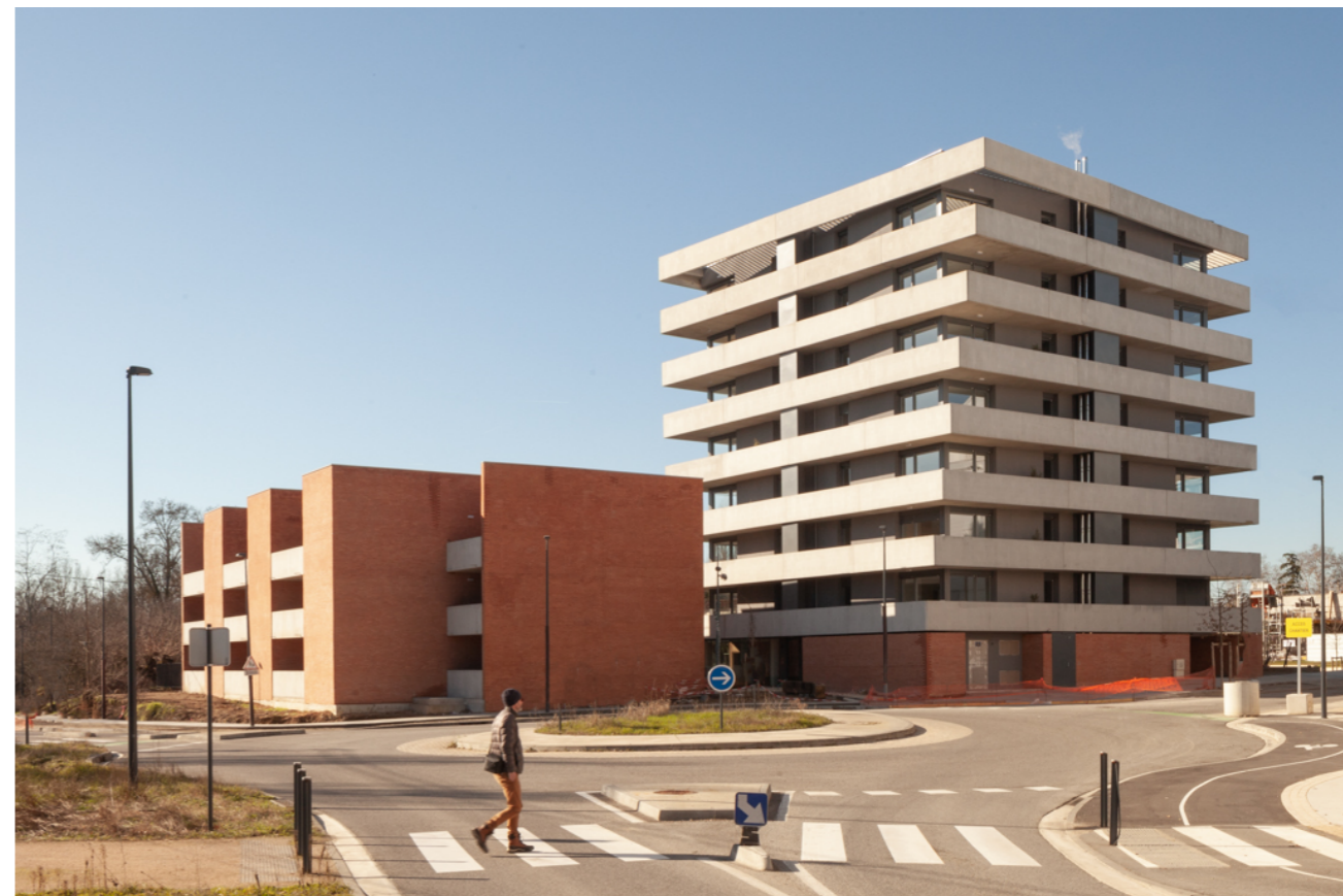
Depuis la route de Tournefeuille, la cheminée de la chaudière collective bois fume. From the Tournefeuille road, the smoke from the communal wood boiler chimney is visible.
