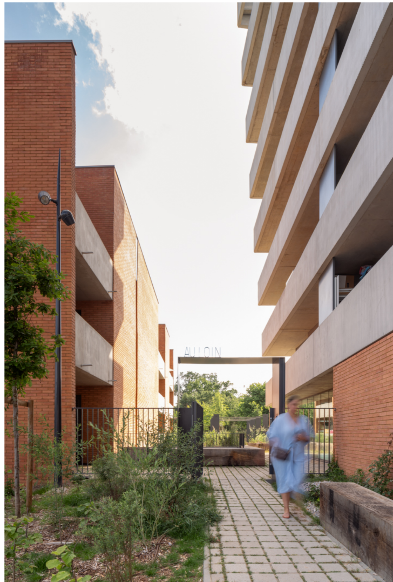
Entrée principale de la résidence. Main entrance of the residence.
