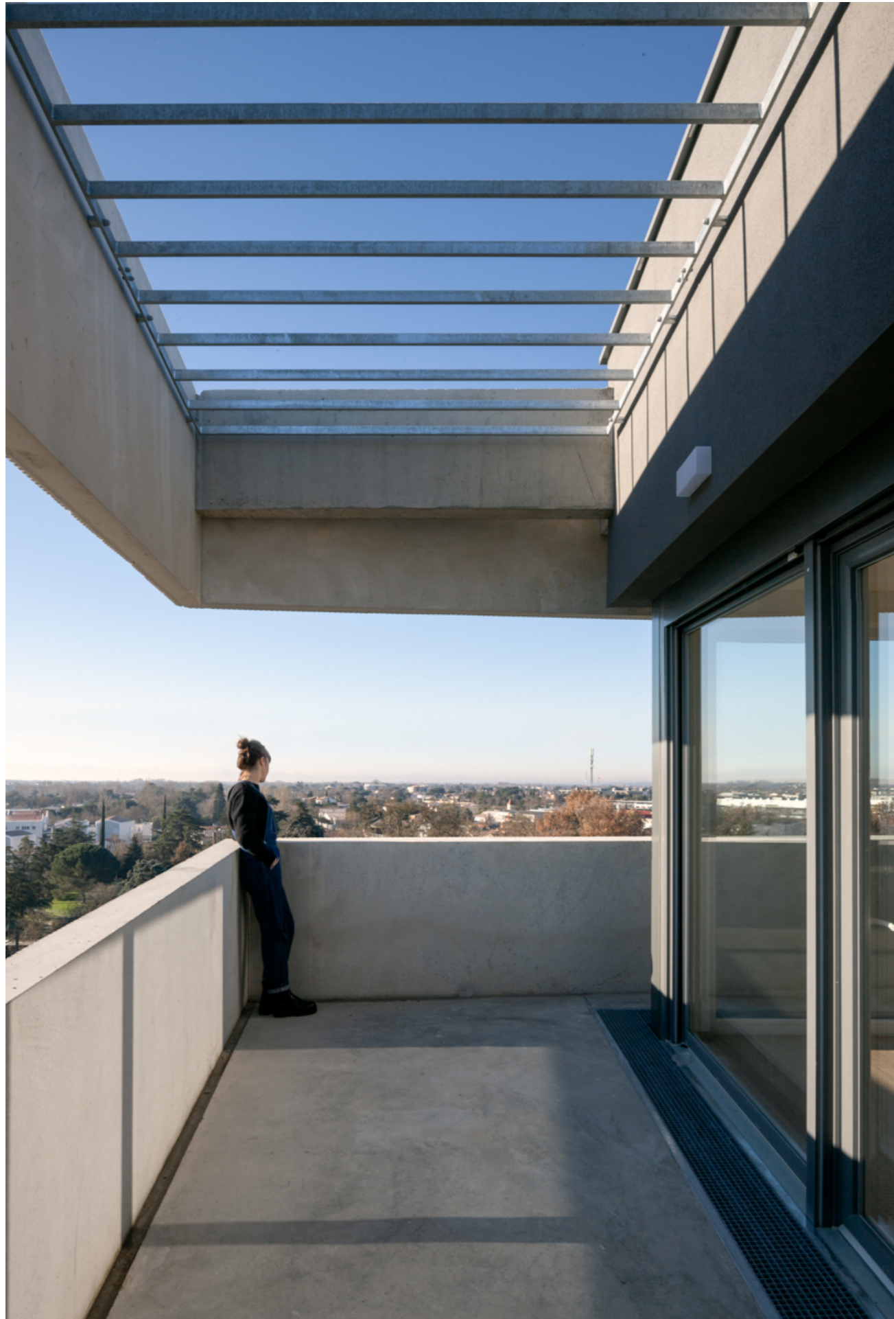
La poutre périphérique en couronnement du dernier étage est comme 8 ème étage. The peripheral beam crowning the top floor functions as the eighth floor.
